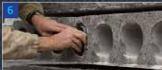
6 CELDEX AIRSEAL VULBLOKKEN & STROKEN – ALS LUCHTDICHTING VAN KANAALPLAATVLOEREN EN WONINGSCHEIDENDE SPOUW
