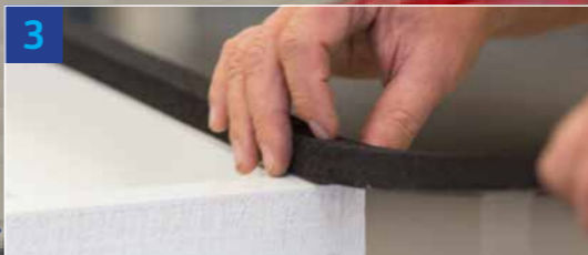
3 CELDEX EPDM STELKOZIJNBAND – ALS DUURZAME LUCHTDICHTING VAN STELKOZIJNEN OP KALKZANDSTEEN EN BETONNEN SPOUWBLADEN
