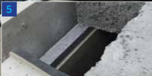
5 CELDEX VILT & SEAL – ALS OPLEGGING EN LUCHTDICHTING VAN VLOERELEMENTEN
